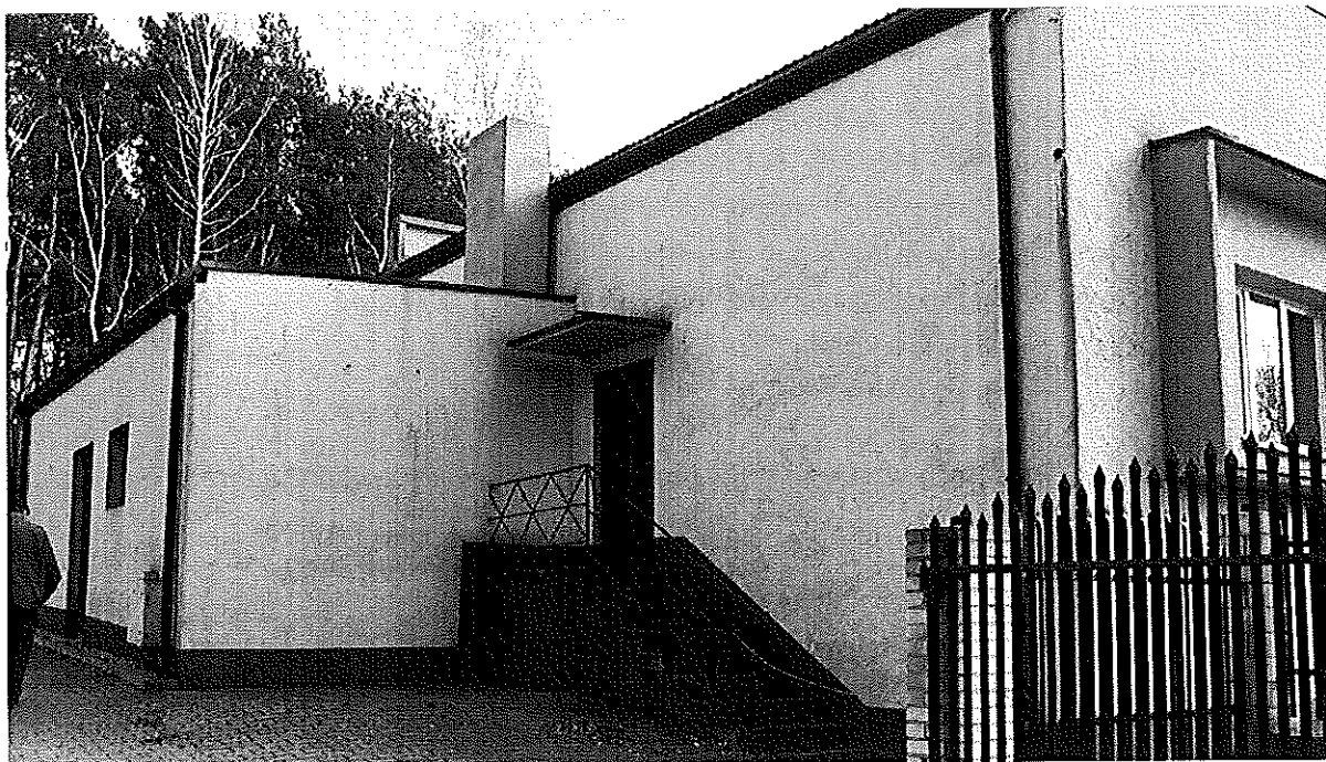
Fotografia 7 Schody wejściowe od strony północnej
