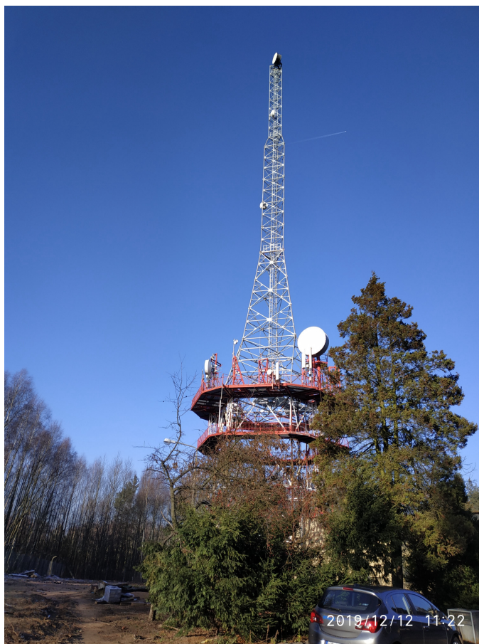
Stacji Linii Radiowych Łódź Dąbrowa – wieża telekomunikacyjna
