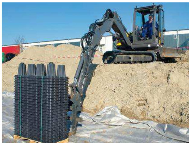
Niewielkie gabaryty i poręczność na placu budowy
