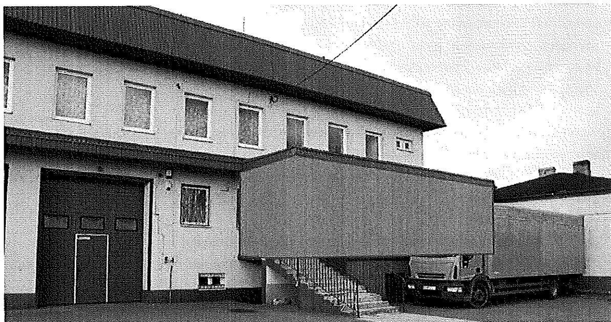
Fotografia 8 Fragment elewacji południowej wyłączony z termomodernizacji objętej audytem
