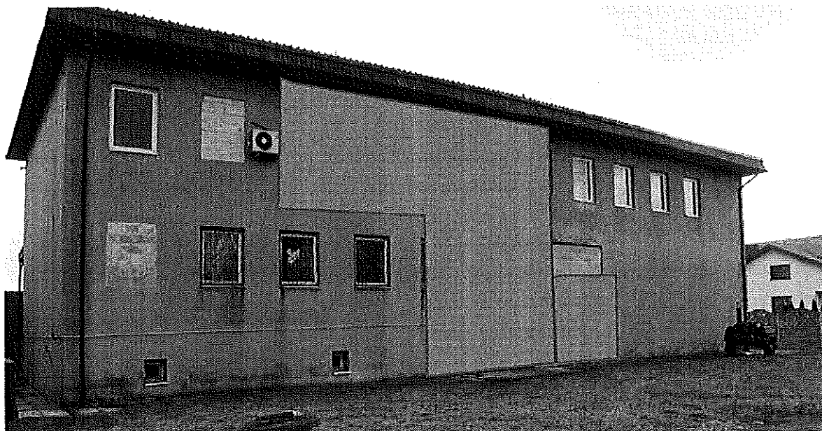
Fotografia 7 Fragment elewacji północnej wyłączony z termomodernizacji objętej audytem
