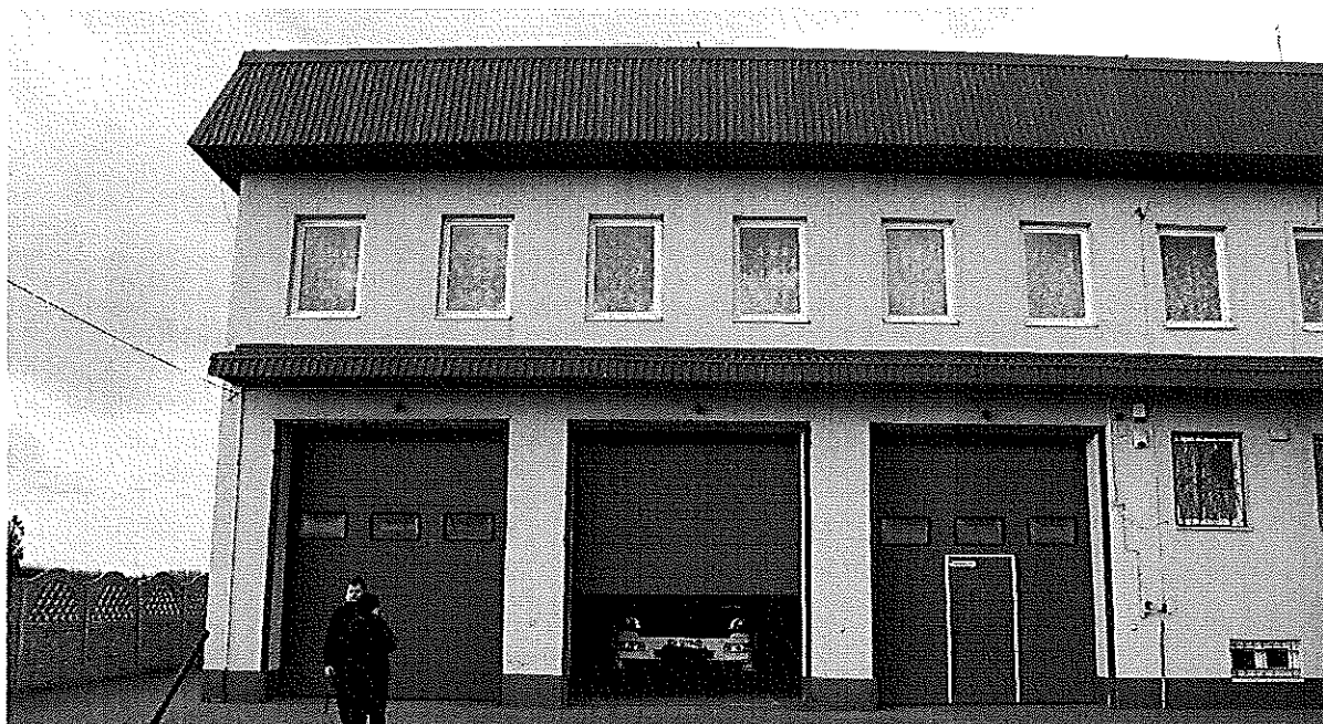
Fotografia 3 Bramy garażowe - elewacja południowa
